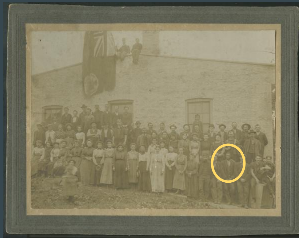
Employés d'une usine de textiles (GA227-3-17)
