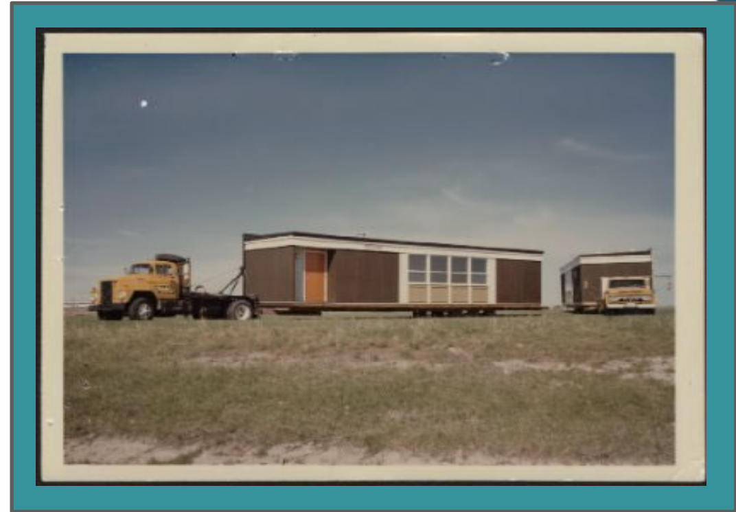
École de jour préfabriquée en cours de livraison sur le site, Forest, Ontario, vers 1967, e011794878
